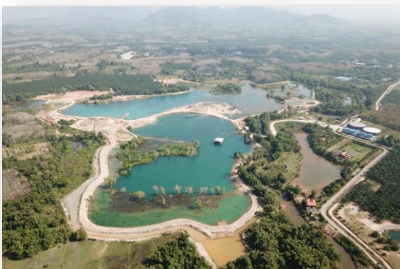
พื้นที่บ่อกักเก็บน้ำดิบกว่า 340 ไร่ ตั้งอยู่ริมคลองบางทอง ณ อำเภอท้ายเหมือง จังหวัดพังงา ปัจจุบันความจุ 4 ล้าน ลบ.ม. (กำลังขุดขยายให้เป็น 9 ล้าน ลบ.ม.)
